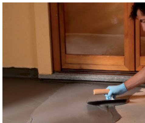
Impermeabilización de arqueta de hormigón a brocha
