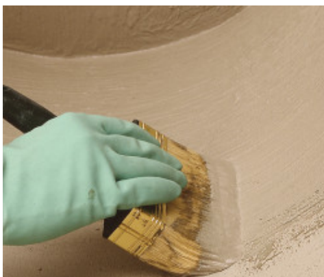
Impermeabilización de muro de cimentación a brocha
